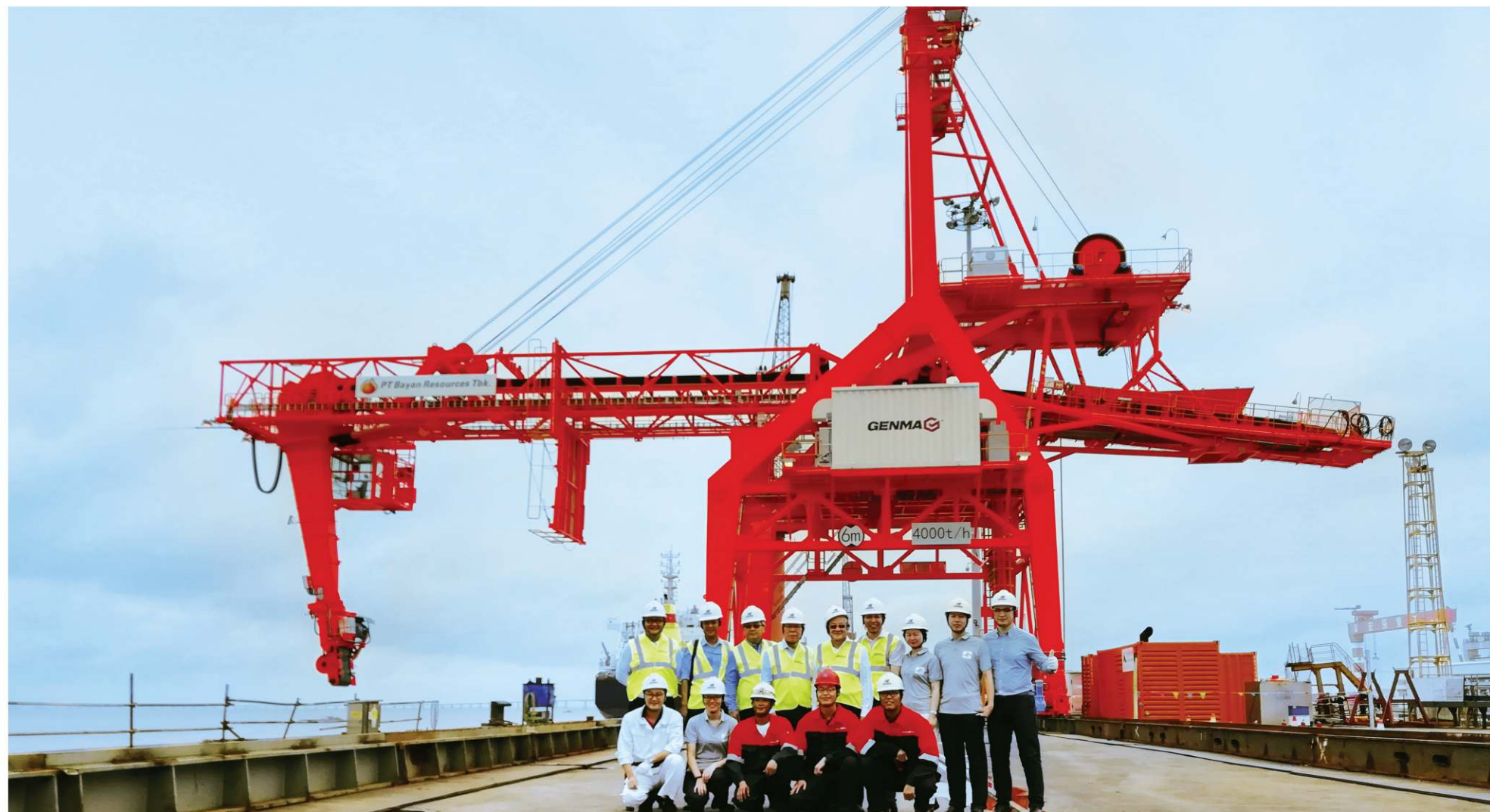
图：GENMA装船机交付至印尼最大煤炭码头巴厘巴板煤炭码头。
